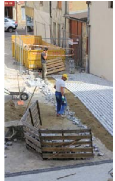
Pose méticuleuse des pavés en granit sur le parvis (côté rue Paul Doumer)
