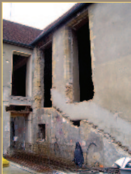
Les trous béants d'une façade aveugle
